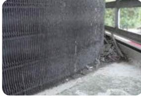
熱交換器下部の腐食
