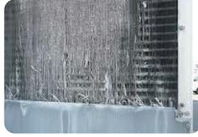
室外機の熱交換器表面の飛散水による腐食
